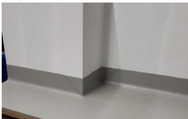
Figure 1a : Travaux de revêtement de sol avant démarrage travaux revêtement mural
