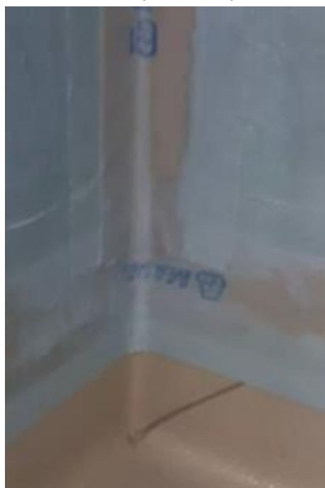
Figure 1c : Chevauchement de la bande de protection de l'angle au-dessus de la bande de renfort
