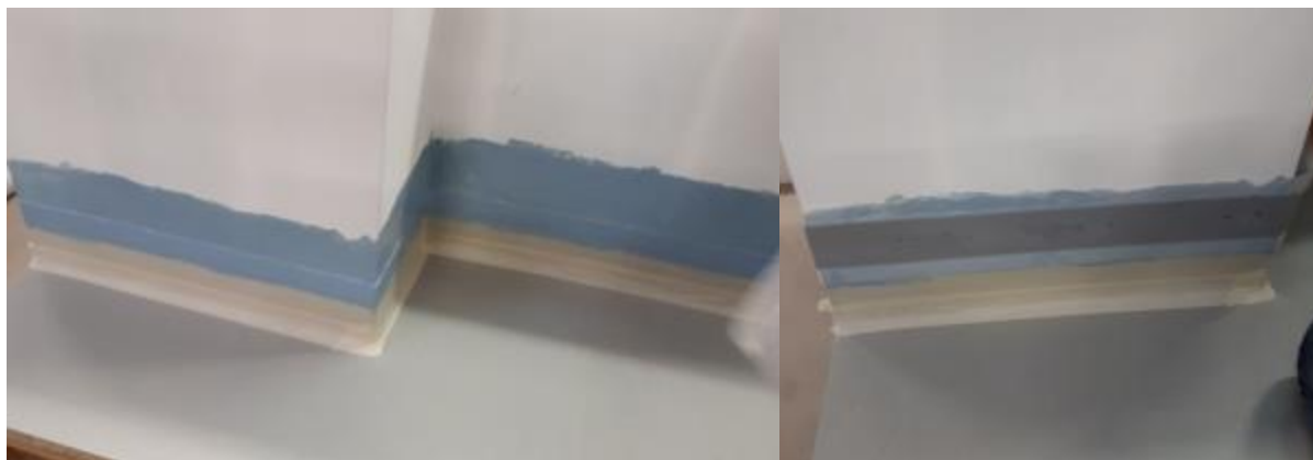
Figure 1b : Application de la 1ère passe (à gauche) et pose bande de renfort (à droite)
